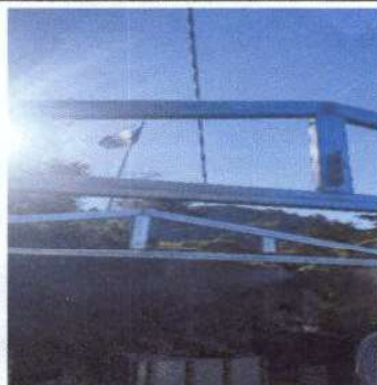
Foto1: Sustitución de lámina, por lámina troquelada calibre 26 y soporte de madera por metal.
