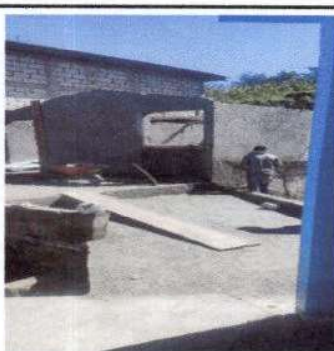
Foto 6: Reparacion de tubería y plancha de concreto de patio.
