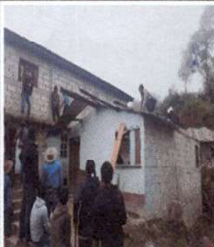
Foto1: Sustitución de lámina, por lámina troquelada calibre 26 y soporte de madera por metal.
